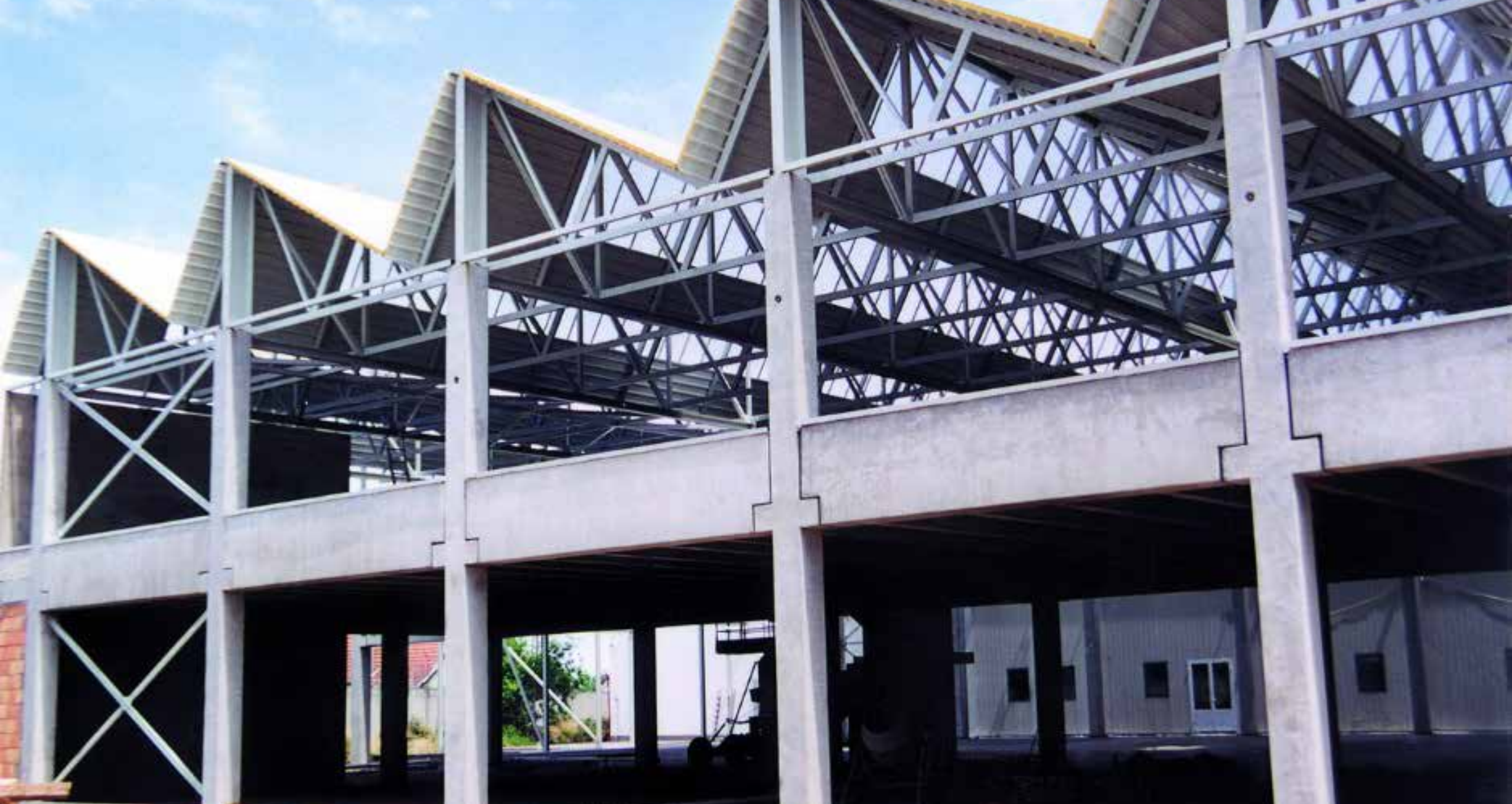
Előregyártott szerkezet / acél rácsszerkezet lefedés
