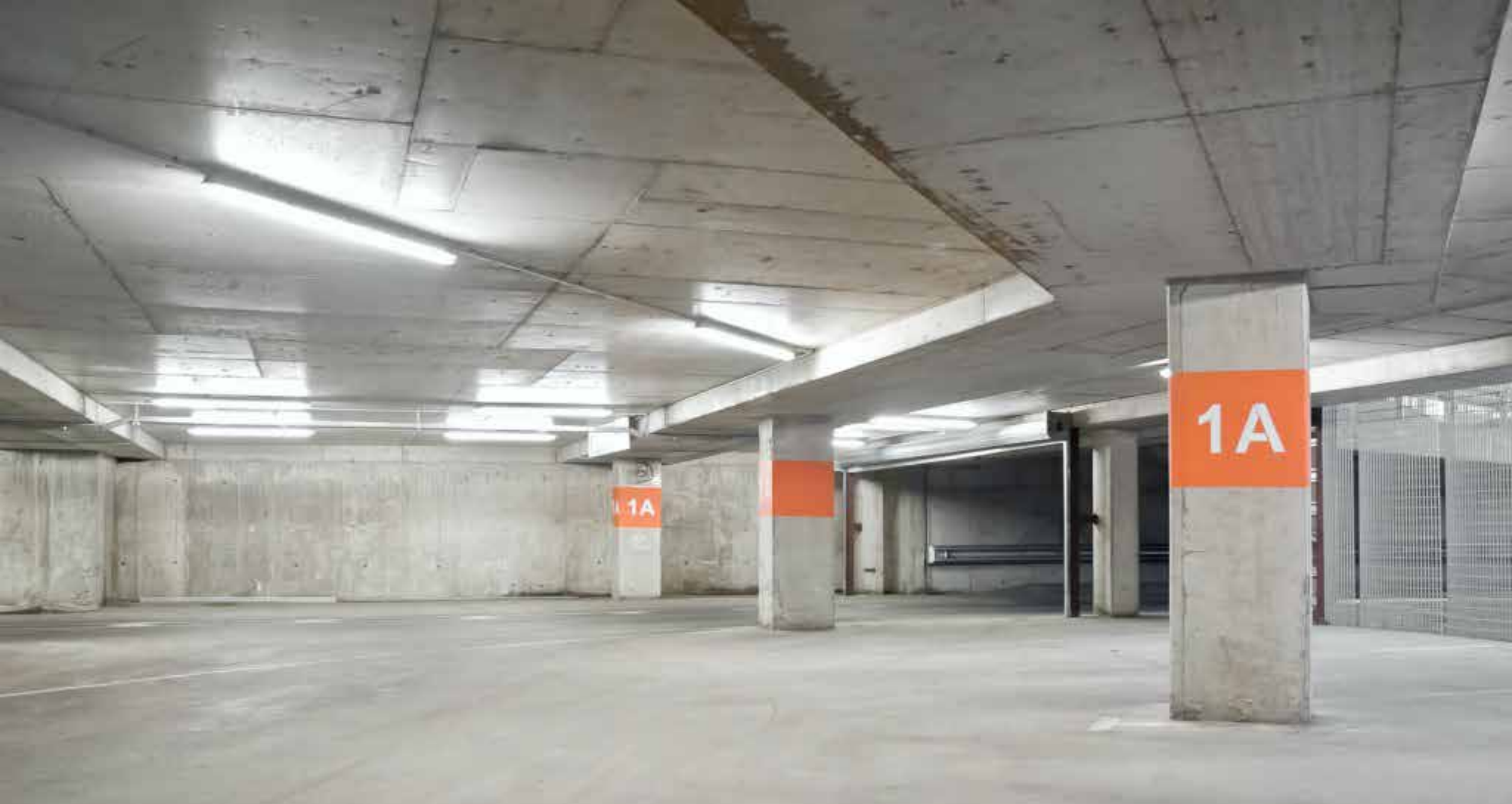
Parkolóház / látszó monolit vasbeton szerkezet
